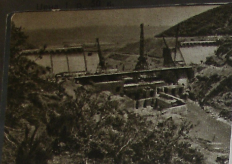
Возводя невиданную прежде в маленькой Албании мощную электростанцию, строители используют опыт советских рабочих и инженеров-энергетиков
